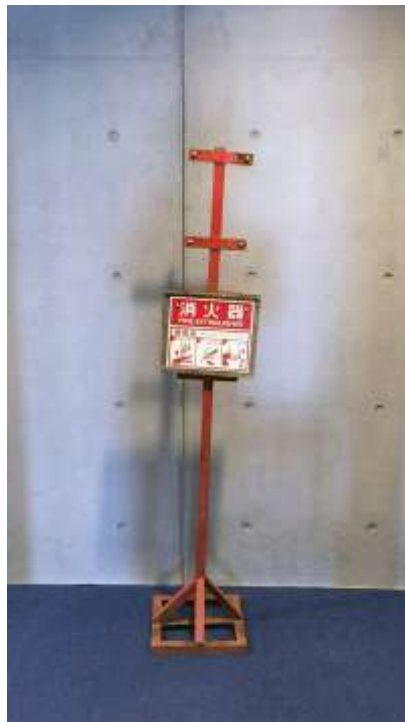
・消火器置き【倉庫】
